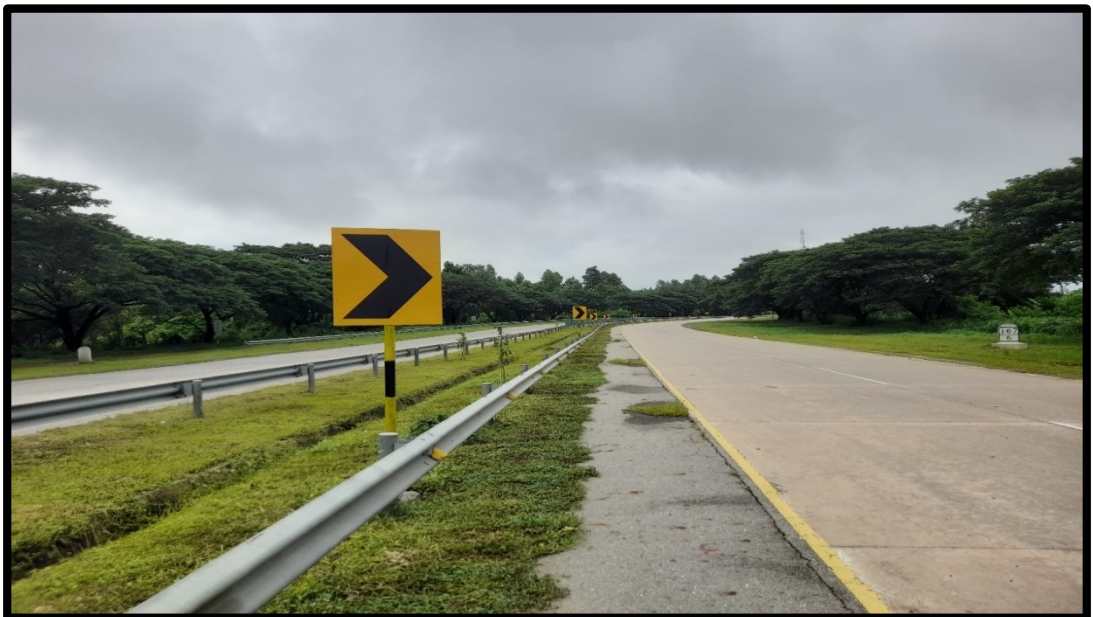
အမြန်လမ်းတွင် Road Sign တပ်ဆင်ဆောင်ရွက်မှု
